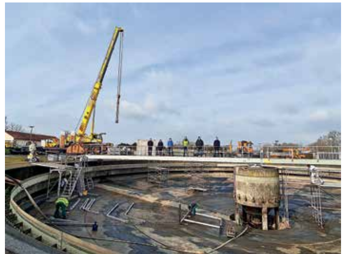
Foto: Sanierung Kläranlage (Stadt Mengen)
