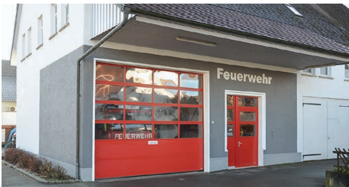
Renoviertes Gerätehaus Vilsingen.
