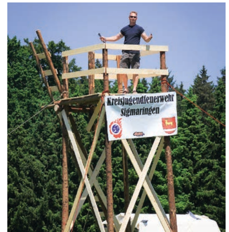
Nils Fritze auf dem frisch errichteten Lagerturm.
