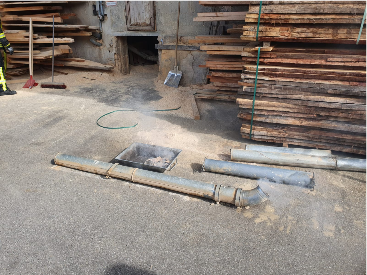
Teile des demontierten Rohrsystems
