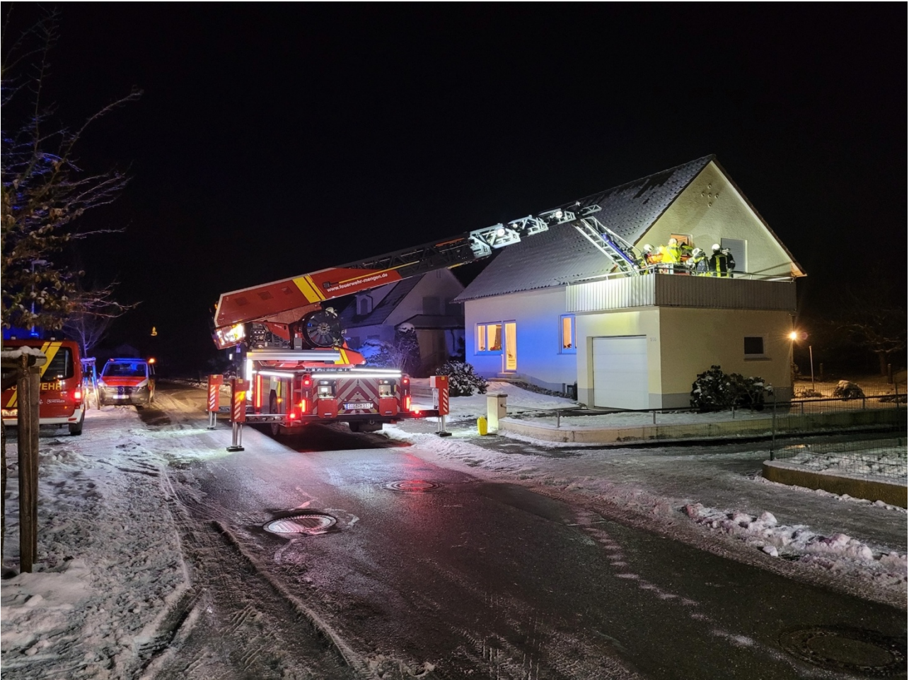
Mit Hilfe des Gelenkteils der Drehleiter kann der Korb auf der Dachterrasse abgesetzt werden
