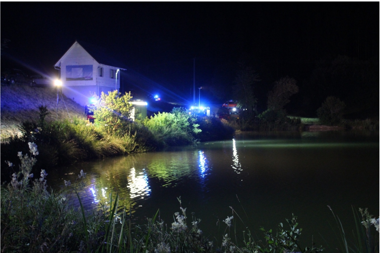
Der Stausee wurde durch mehrere Lichtmasten ausgeleuchtet
